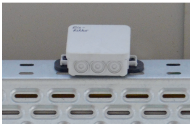
Verteilerdosen magnetisch befestigen
