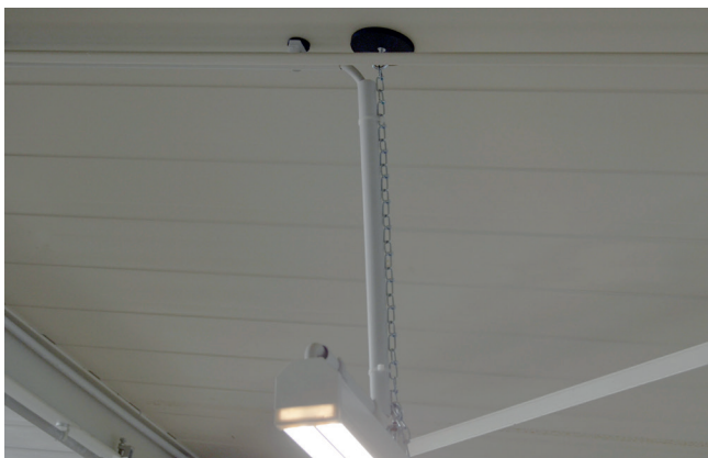
Leuchten von Decke abhängen
