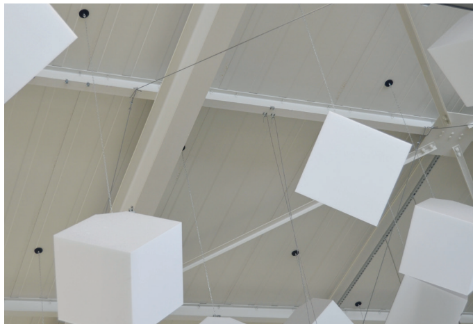
Abhängung von Schallschutzelementen
