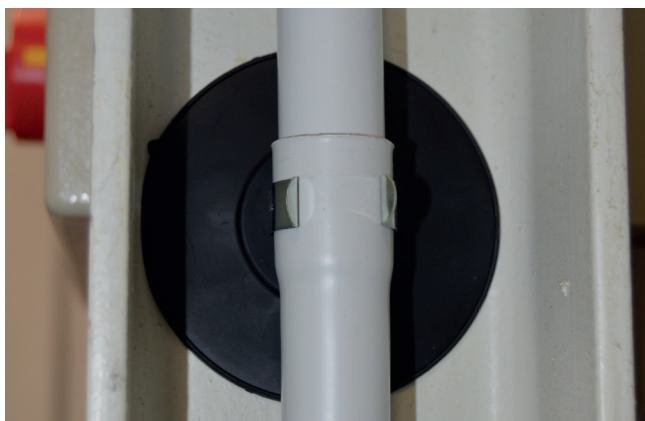
Befestigung von Rohren direkt an Stahlträgern
